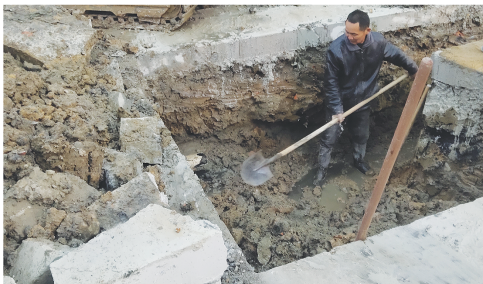
施工人员冒雨作业
