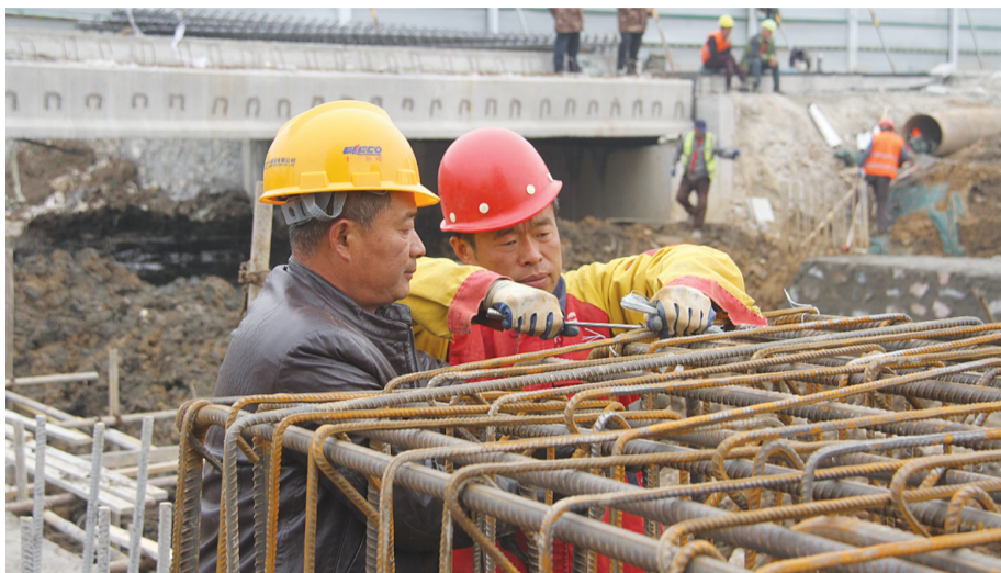
新汉城河桥钢筋捆扎作业现场
