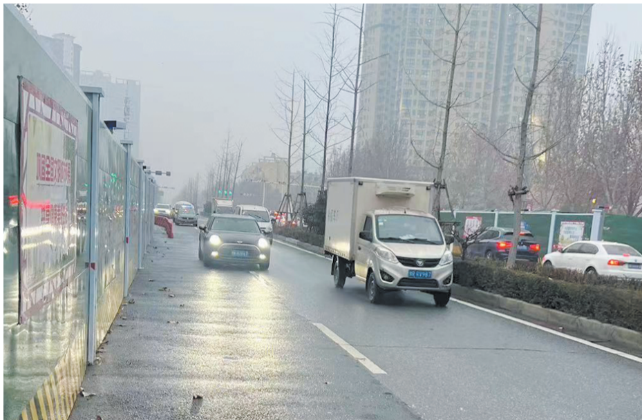
车站南路地下过街通道南北主车道通车
