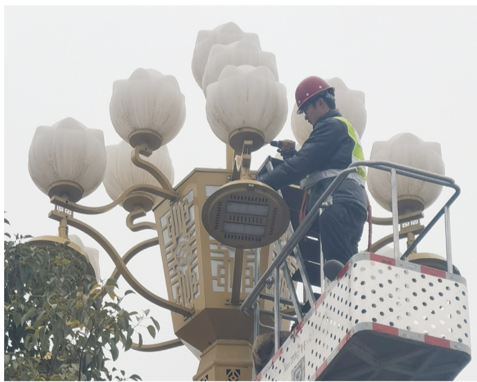
工作人员检修路灯
