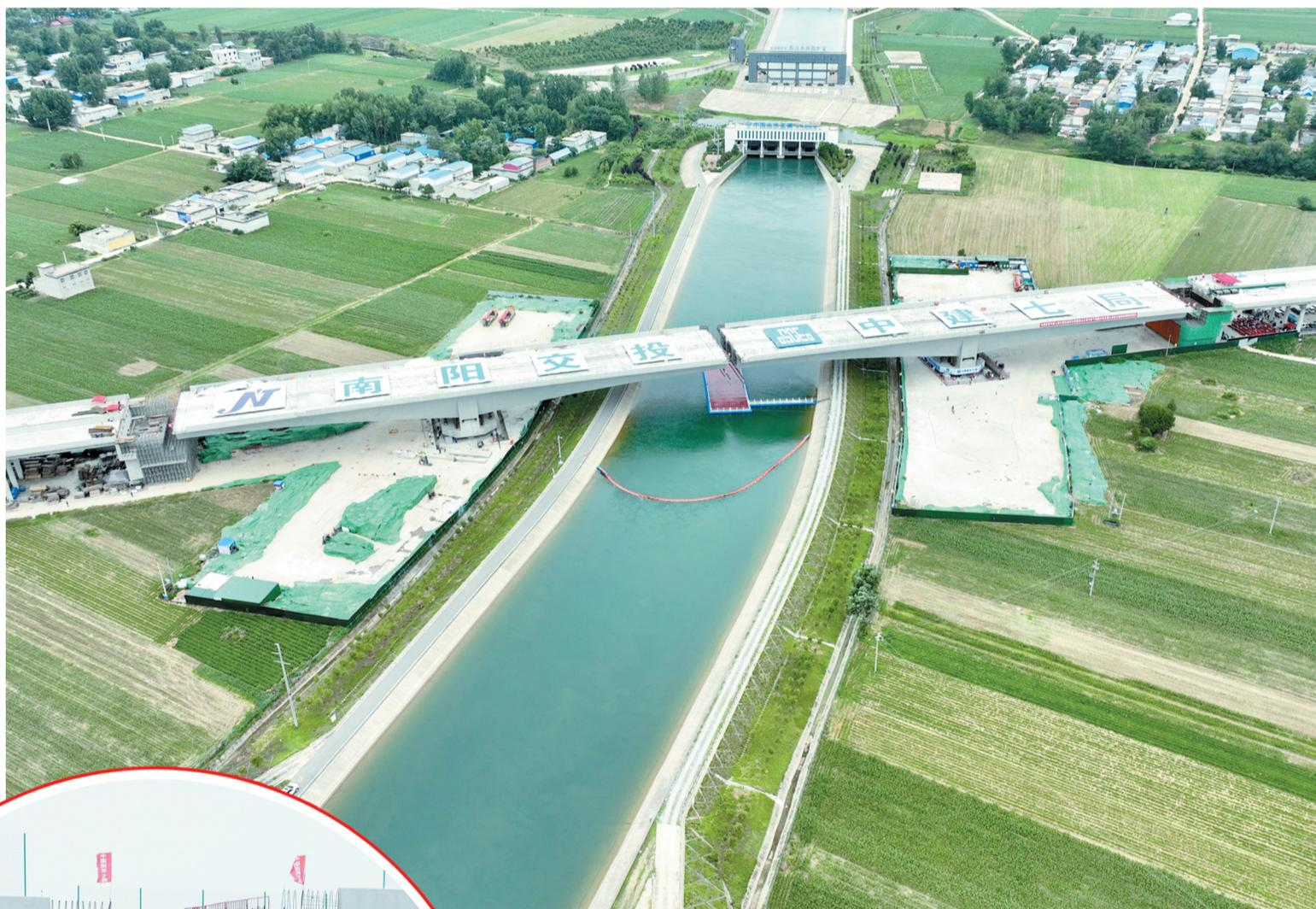
7月1日，焦作至唐河高速公路方城至唐河段1标段跨南水北调中线干渠特大桥成功转体对接。这标志着方唐高速公路向全线通车迈出了关键一步。⑩1
