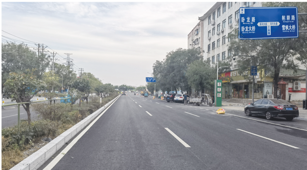
中心城区工业路(建设路至滨河大道段)改造提升项目即将建成通车
