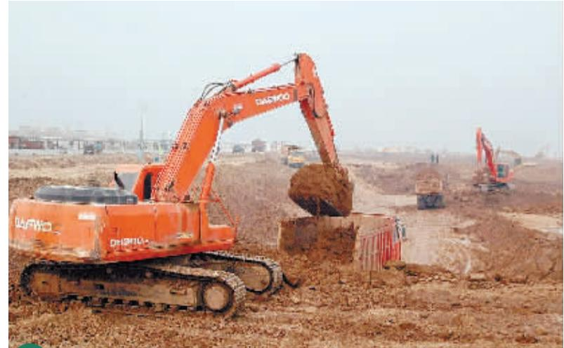
**2 淅川段工程:**起于淅川县陶岔渠首,止于邓州朱岗村北、邓州与镇平交界处,长50.7公里;明渠过水,设计水深8米,渠道底宽10.5米~13.5米;挖方渠道开口线外两侧设保护范围宽13米。
