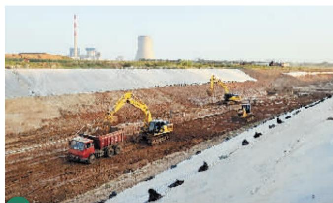
**6 南阳膨胀土试验段工程:**位于卧龙区靳岗街道,全长2.05公里。渠道断面为半挖半填渠道和挖方渠道,渠道最大挖深约19.2米,最大填高5.5米。
