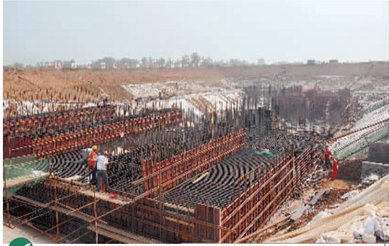
**4 镇平段工程:**起点在邓州和镇平交界处,终点位于镇平县和卧龙区交界处,长35.8公里,明渠输水,沿线布置大小建筑物61座。
