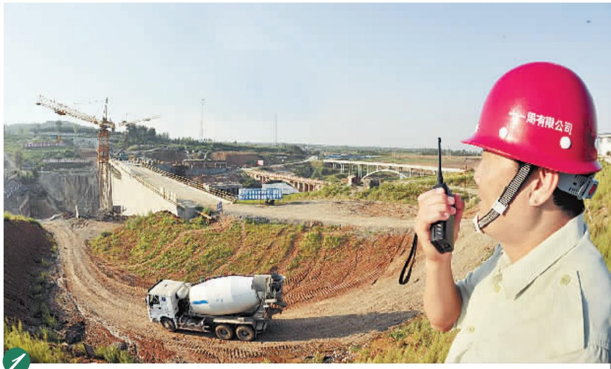
**1 陶岔渠首枢纽工程:**国家大型水利工程,是南水北调中线一期工程输水总干渠的引水渠首,兼顾灌溉、发电。工程位于淅川县九重镇陶岔村,主要包括上游引渠护坡,挡水建筑物(重力坝、引水闸及水电站)、闸下消力池及电站尾水渠、两岸岸坡防护、交通桥及管理设施等,计划2013年11月30日竣工。
