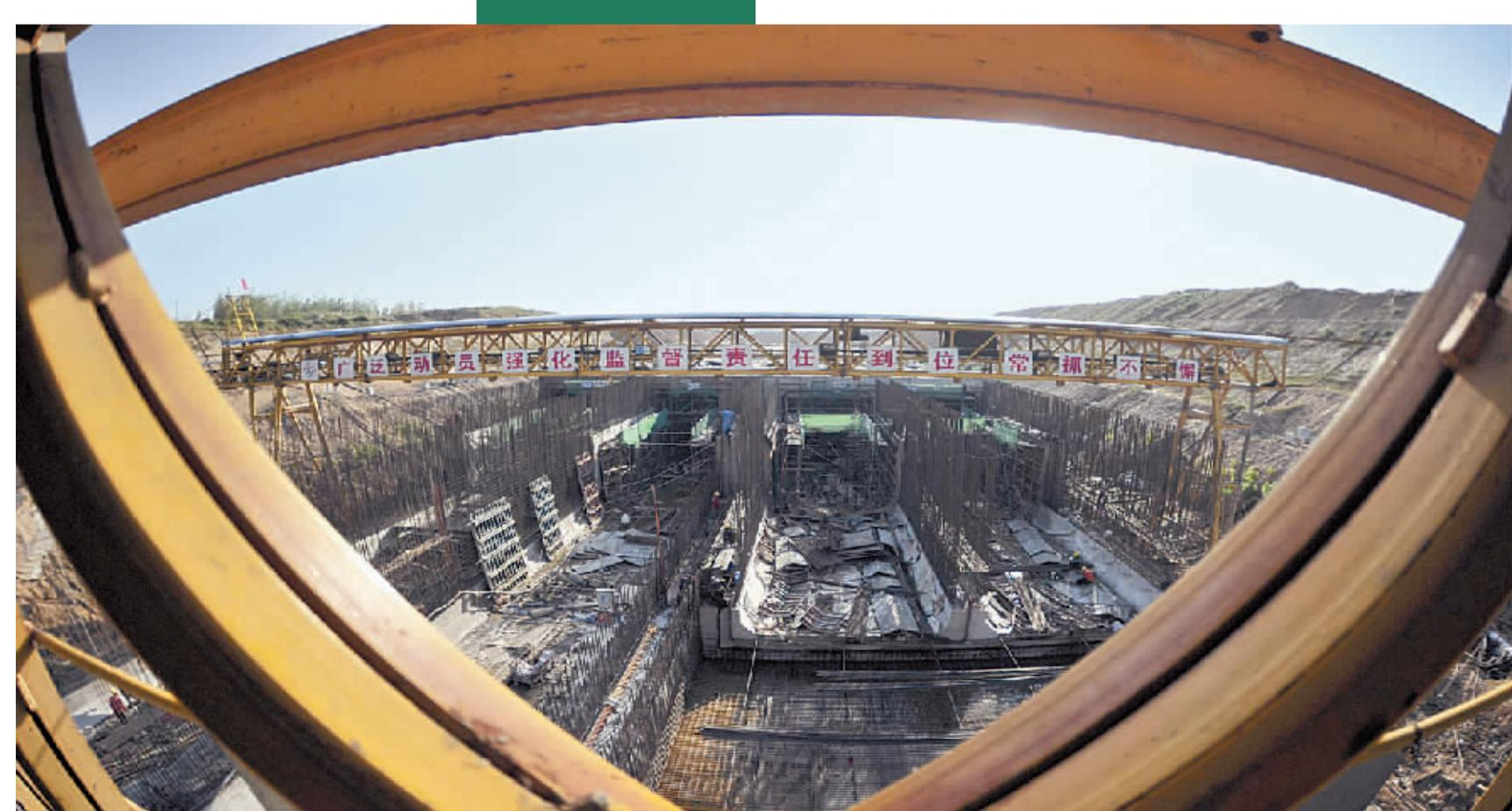
**7 白河倒虹吸工程:**距南阳市中心城区北约15公里,由进口至出口依次为进口渐变段、退水闸及过渡段、进口检修闸、倒虹吸管身、出口节制闸(检修闸)、出口渐变段。埋管段为两孔一联共4孔的混凝土管道。
