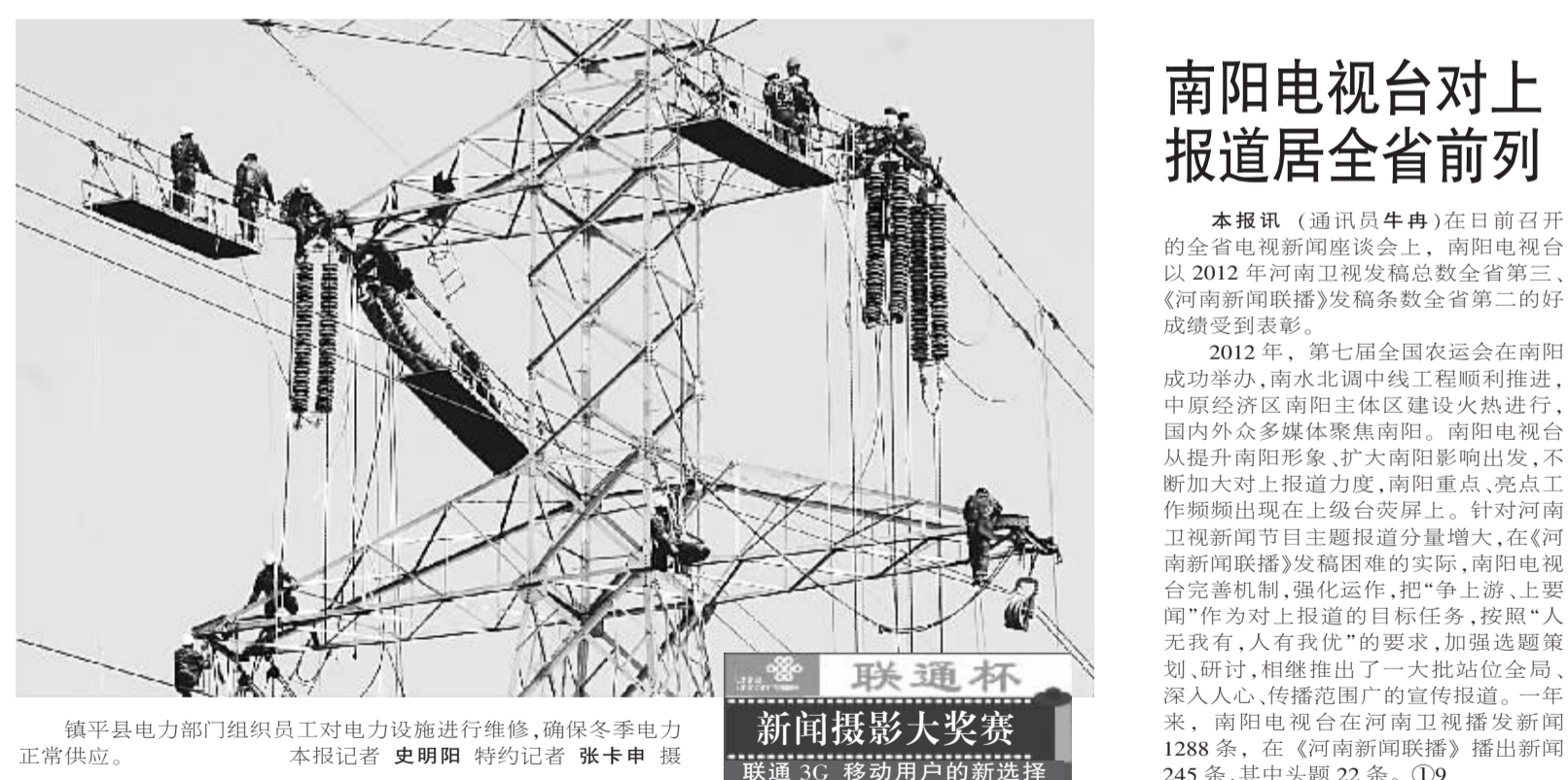
镇平县电力部门组织员工对电力设施进行维修,确保冬季电力正常供应。 本报记者 史明阳 特约记者 张卡 申 摄
