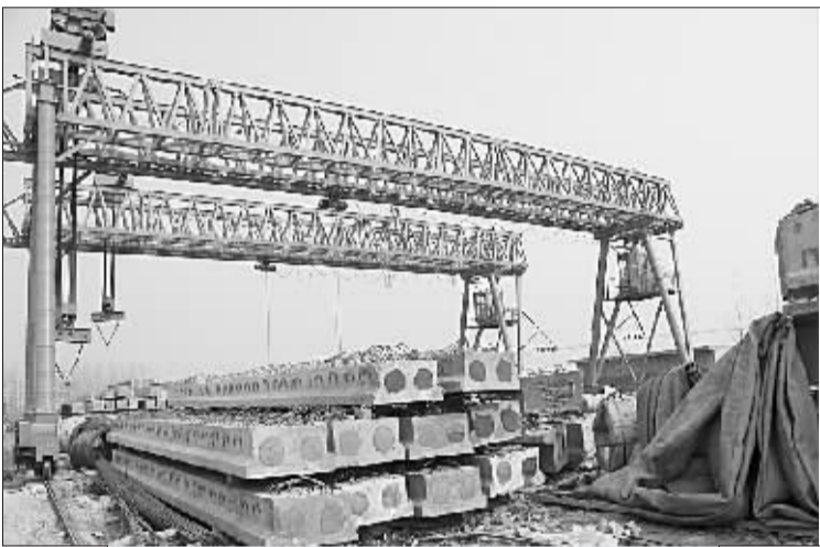
红泥湾镇:建设工地忙
