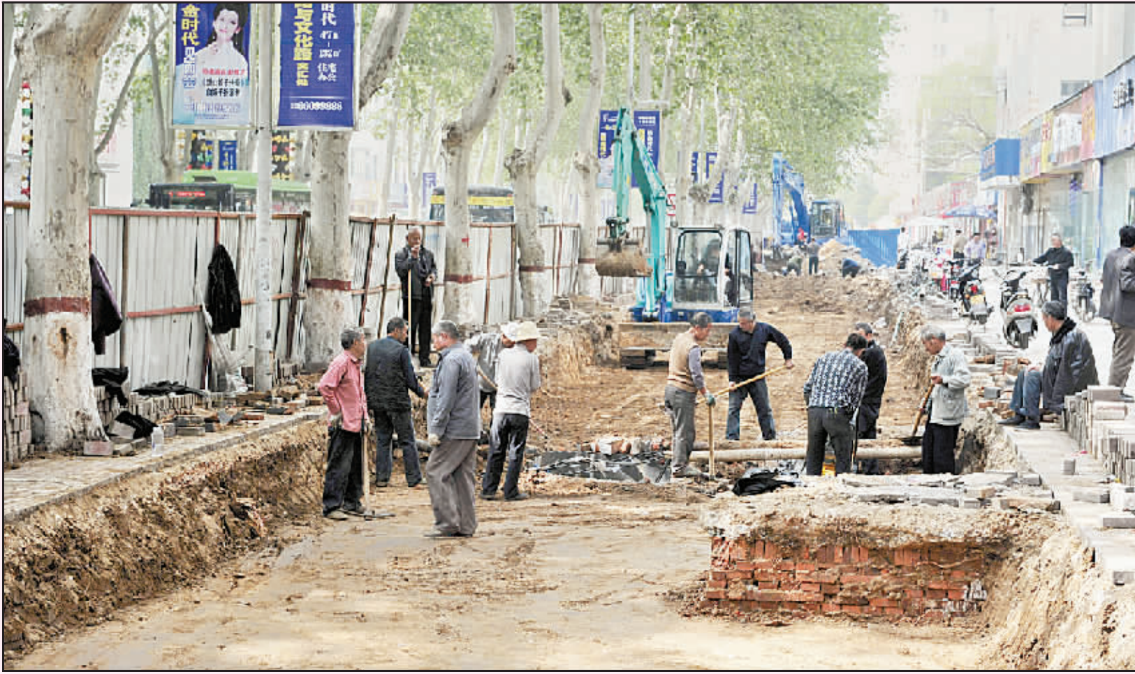
连日来,我市对文化路、工农路等多个路段进行改造,以解决交通拥堵问题。图为文化路南段道路改造施工现场。
