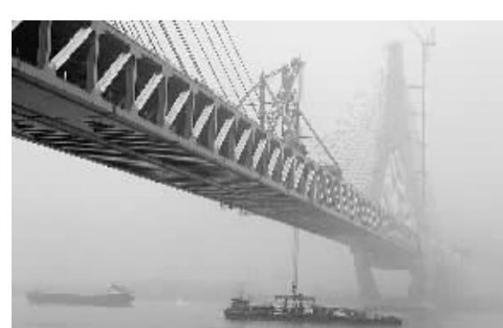
12月19日，京福（北京至福州）高铁跨越长江的控制性工程——安徽铜陵长江公铁两用大桥顺利实现合龙。该桥主跨达630米，全长51.2公里。刷新了我国公铁两用桥梁跨度的新纪录。标志着我国新一条南北交通大通道京福高铁建设取得重大突破。⑥4
