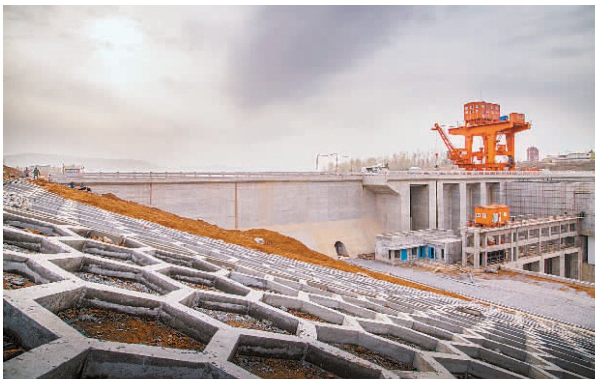
目前,南水北调中线渠首陶岔枢纽工程已进入收尾阶段,施工人员正在加紧铺砌护坡,为迎接通水做准备。 通讯员 国伟 摄
