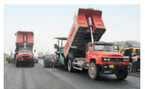
干线公路标准化施工现场
