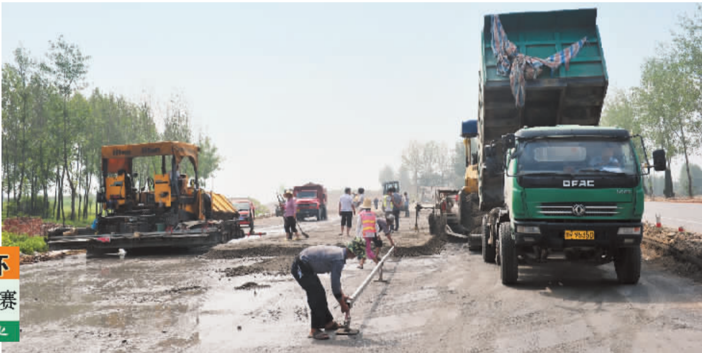
日前,312国道内乡西峡交界至豫陕界段改建工程正在加紧建设,该项目全长71.6公里,双向四车道。目前,路基稳定砂铺设已基本完成。⑮6 本报记者 崔培林 摄
