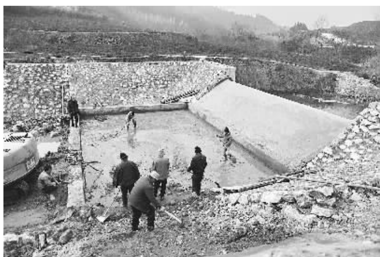
浙川县滔河乡农民修建水利工程,提高农业综合生产能力。 特约记者 夏季风 通讯员 党磊 摄
