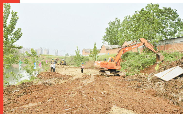
4月18日,梅溪河整治工程开工,大型机械施工拉开整治序幕。 通讯员 李园园 摄
