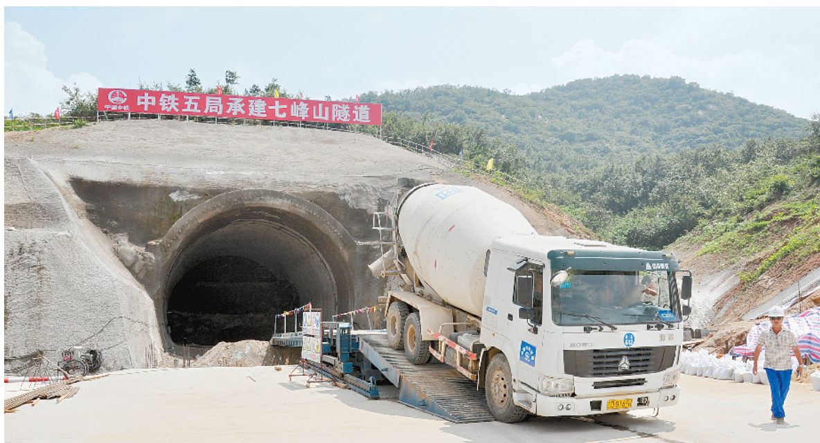
隧道施工现场
