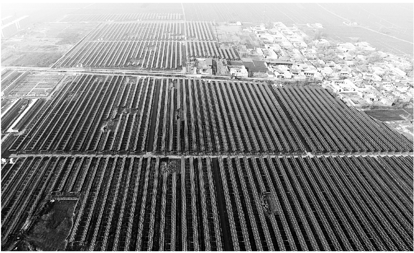
11月23日,河北省任县40兆瓦农光一体化项目(一期20兆瓦)实现并网发电。该项目位于河北省任县永福庄乡,充分利用立体空间,实现棚上发电、棚下种植高效经济作物。项目计划总投资4.3亿元,项目全部完工后年平均发电量约4800万千瓦时。
