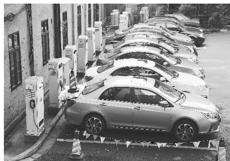
上海市车辆登记部门提供的最新数据显示，2013年到2016年，上海累计推广新能源汽车超过10万辆。图为新能源车在上海徐汇区一处充电站内充电。
