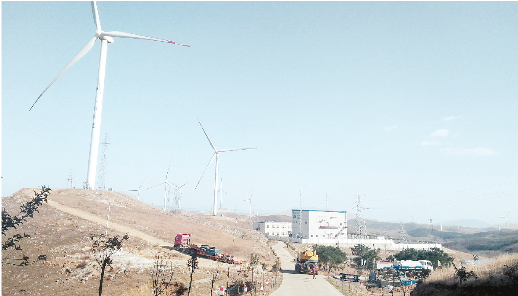
唐河县湖阳镇风电项目总投资7.92亿元,安装35台风力发电机,年发电量可达1600万千瓦时 (3)
