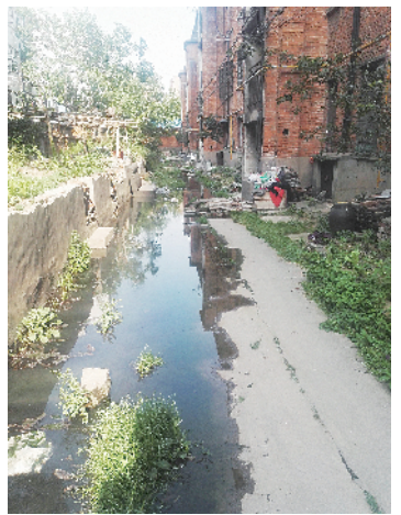
污水中夹杂着粪便,气味非常难闻,年轻人受不了,都租房搬出去了,只留下一些老年人在这里生活。”下水道堵塞、污水横流的问题何时能解决?本报将持续关注。⑮3
