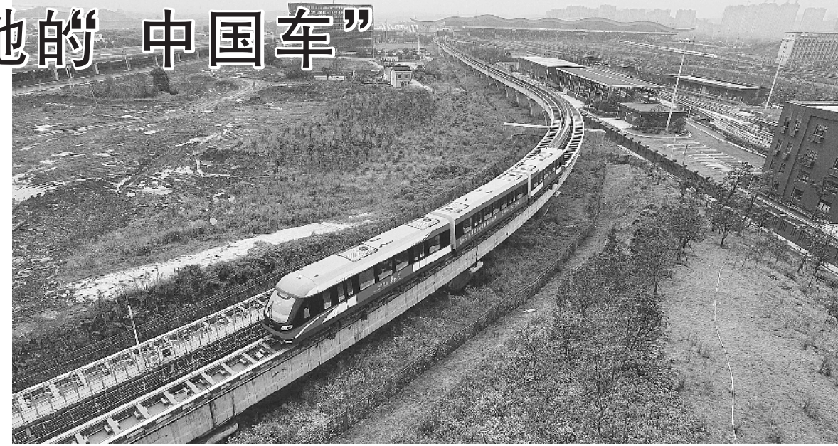
运行中的长沙磁浮快线
