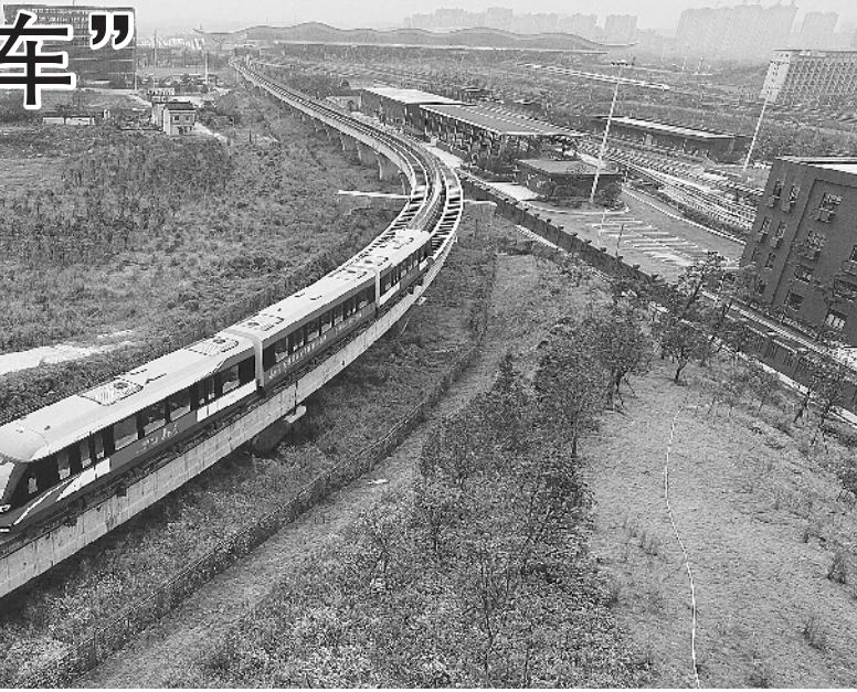
运行中的长沙磁浮快线
