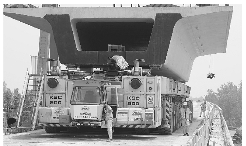
目前,郑(州)万(州)高铁河南段线下工程已经基本完工。郑万高铁全长818公里,设计时速为350公里。图为6月27日拍摄的郑万高铁河南南阳段施工现场 新华社发
