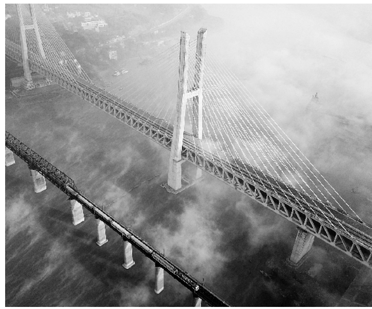
经过 5 年艰苦建设,位于重庆江津的世界首座双层六线钢桁梁铁路斜拉桥——新白沙沱长江特大桥(右)近日落成 ⑤3 新华社发
