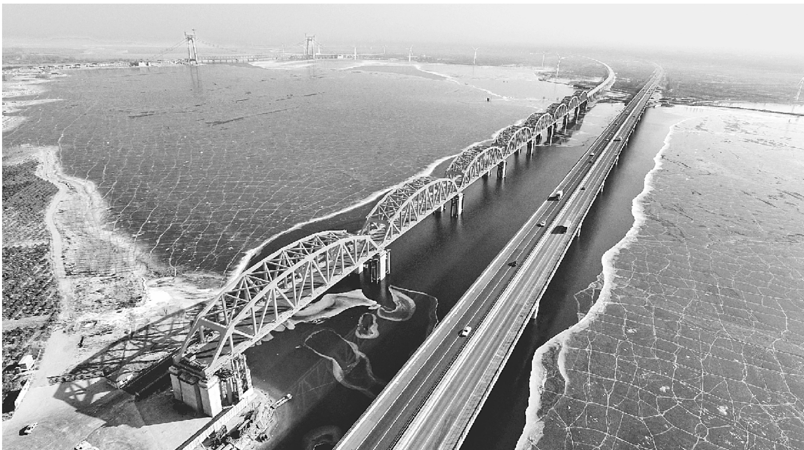
1月16日,京张高铁官厅水库特大桥拱形八孔钢桁梁最后一孔落梁成功,这标志着该特大桥主桥主体结构全部施工完成,桥面附属工程将如期推进。据介绍,官厅水库特大桥全长9077米,是京(北京)张(张家口)高铁重要节点工程。⑤5 新华社发
