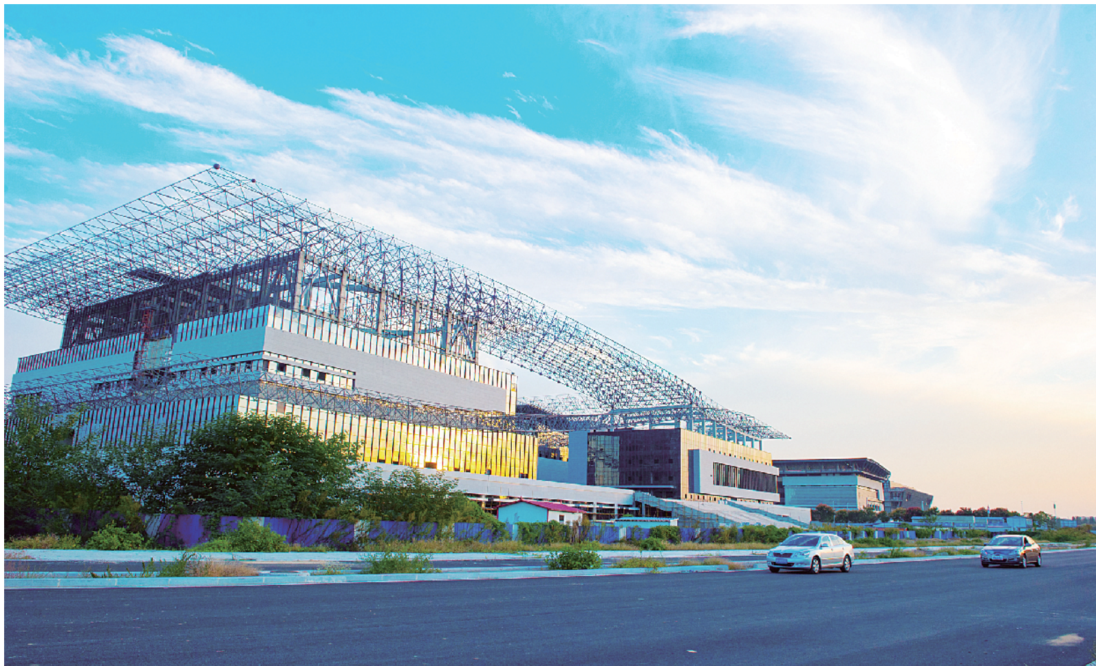
位于城乡一体化示范区的“三馆一院”主体建筑大气磅礴,气势宏伟。目前正在加紧进行内外装饰,计划2019年完工 ③4
