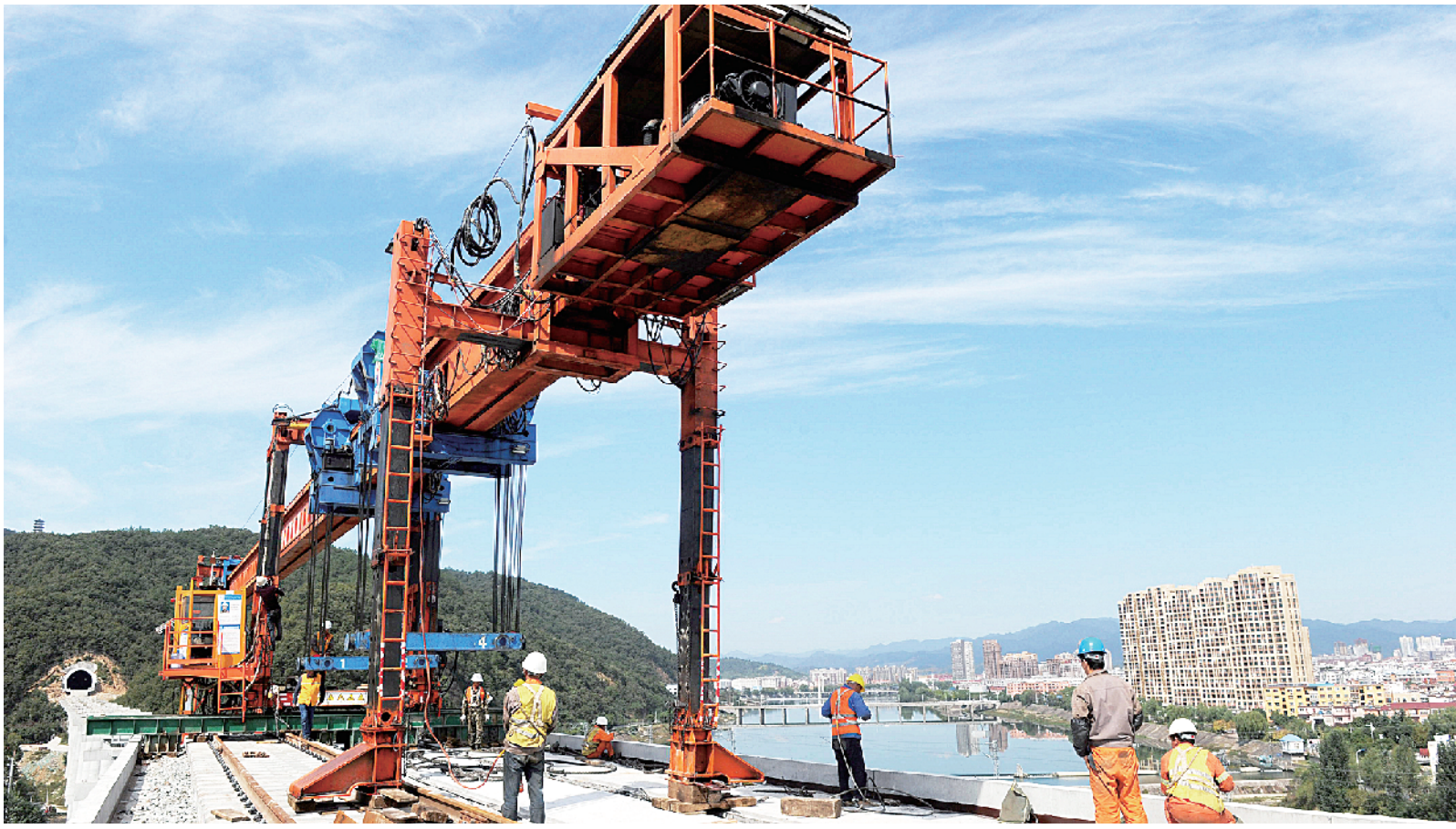
蒙华铁路内西峡境内施工全面进入快车道,桥梁和道轨铺架预计今年年底完成。图为鹤河大桥正在铺架道轨。③4
