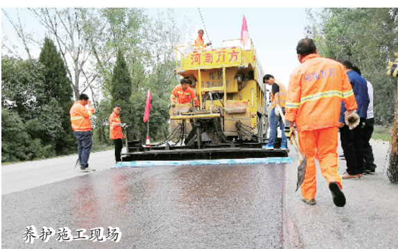
森平施工现场
