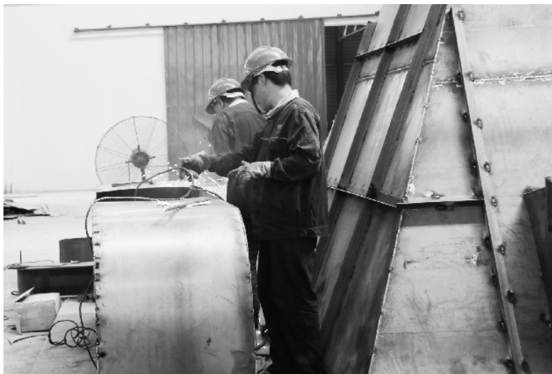
环碧公司焊接车间
