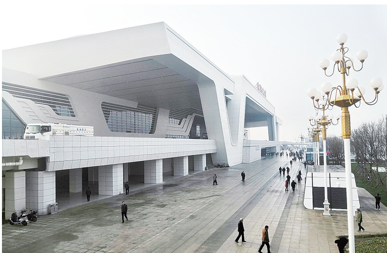
南阳东站正式投入使用
