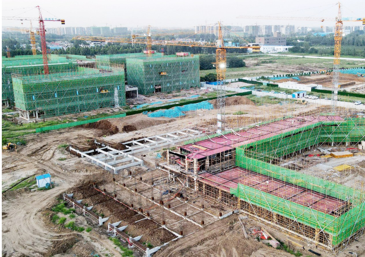
完全学校加紧施工
