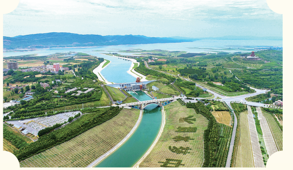
南水北调中线工程渠首
