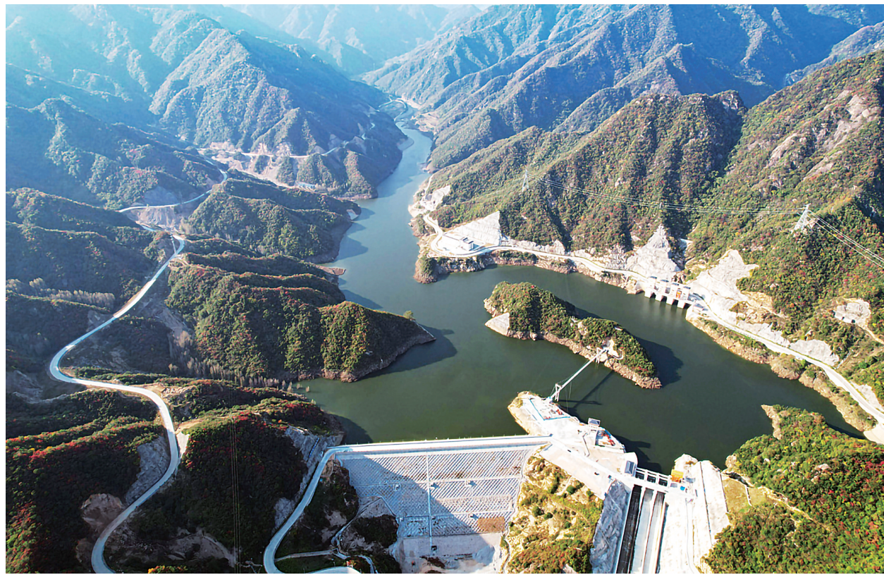
天池抽水蓄能电站下水库雄姿。通讯员 鲁若愚 摄
