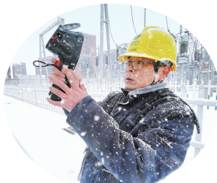
上图:国网南阳供电公司员工在110千伏飞翔变电站蹲点驻守。本报记者 张玲 摄
