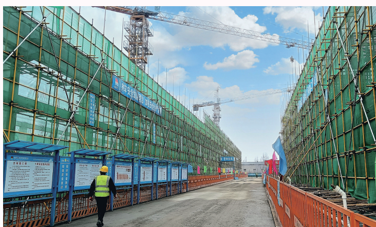
南阳金誉科技有限公司5万吨食品材料包装项目建设现场。
