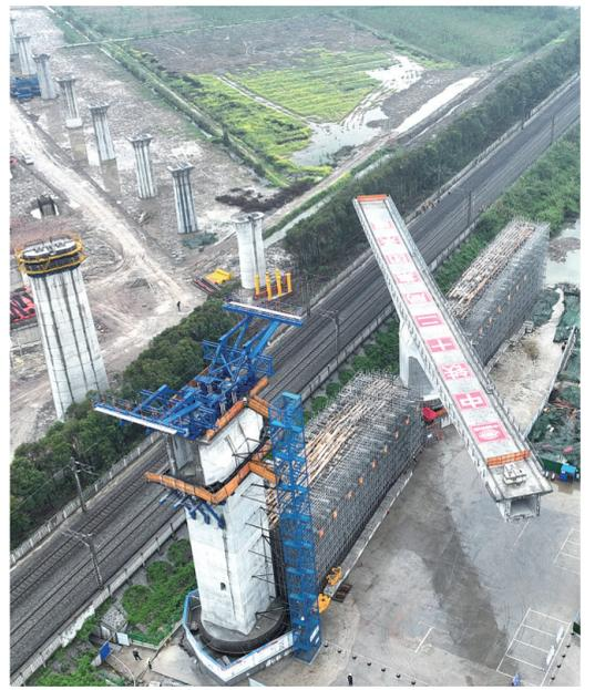
4月2日，沪渝蓉高铁武宜段跨汉丹铁路特大桥转体进行中。沪渝蓉高铁武宜段汉口至汉川东全长44.535公里，包含多处转体桥、斜拉桥等特殊结构物。②9 新华社发
