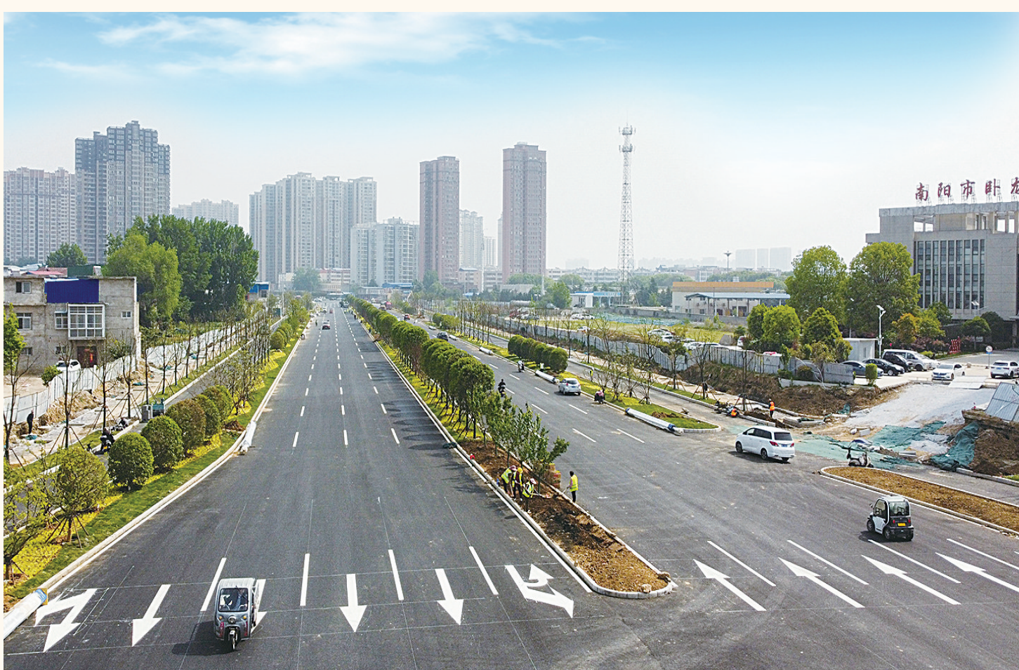
车站南路(雪枫大道—涧河大道段快车道)
