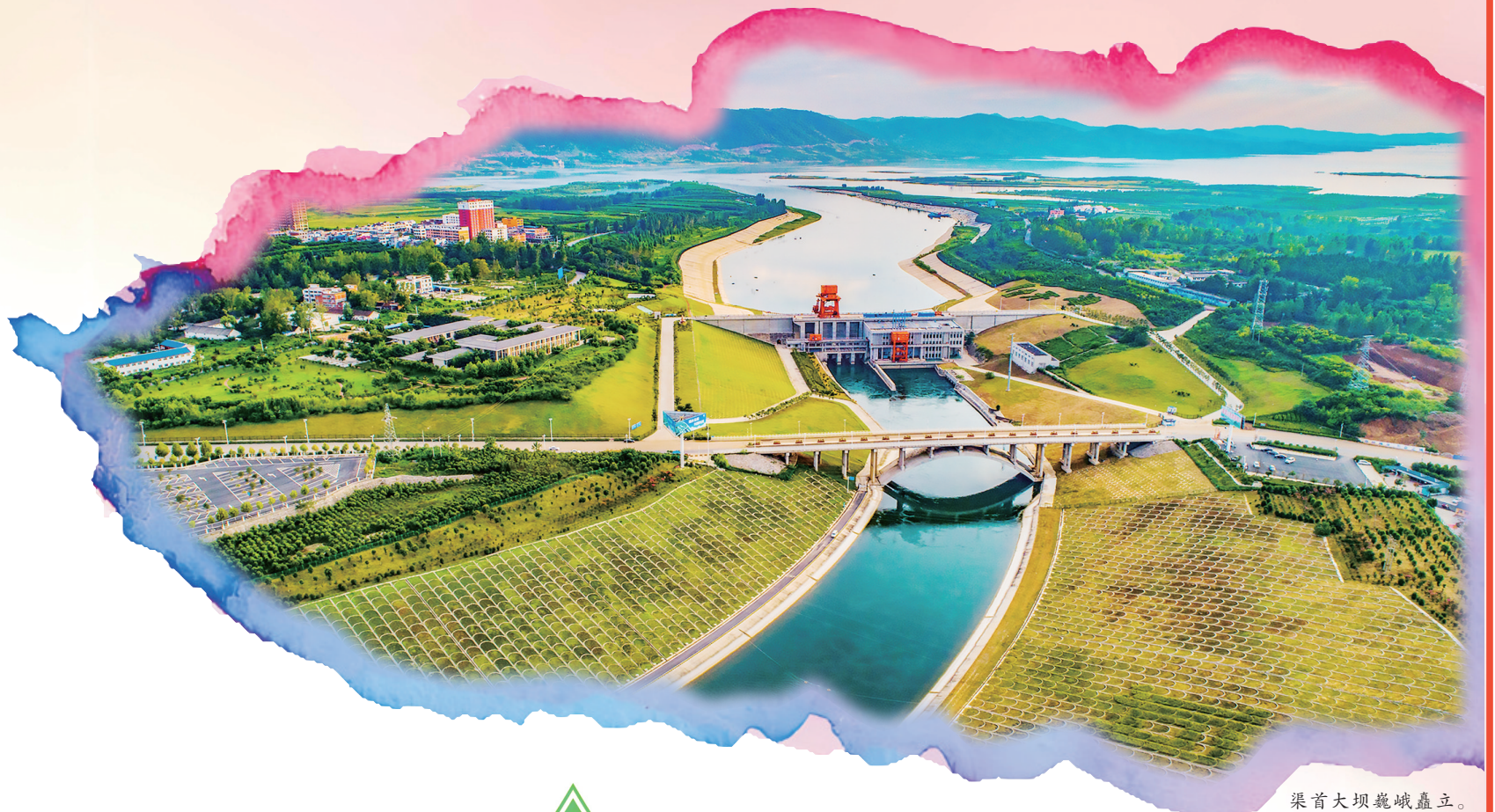
渠首大坝巍峨矗立。
