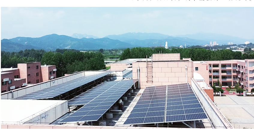
公共机构屋顶光伏发电项目。
