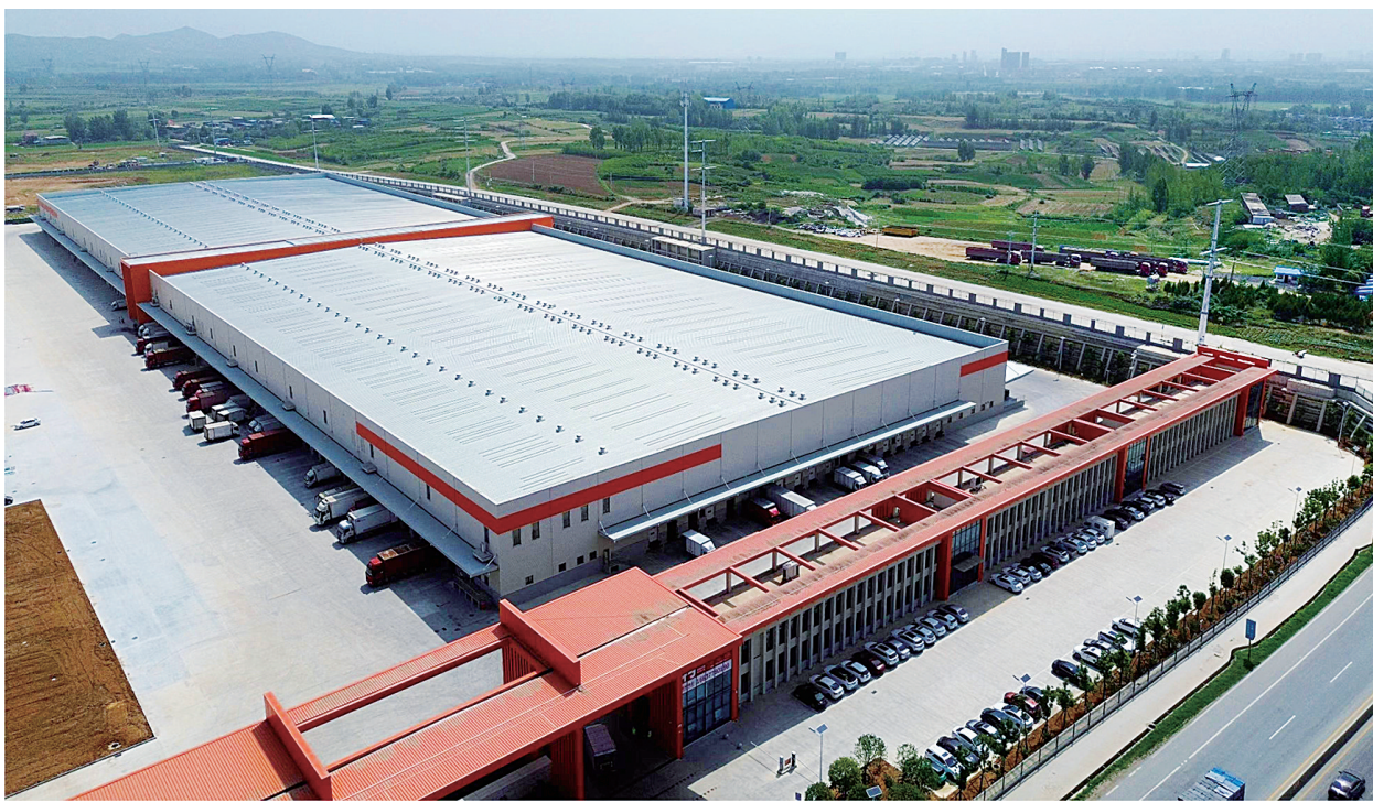
正在建设中的万德隆物流配送中心项目。②5
