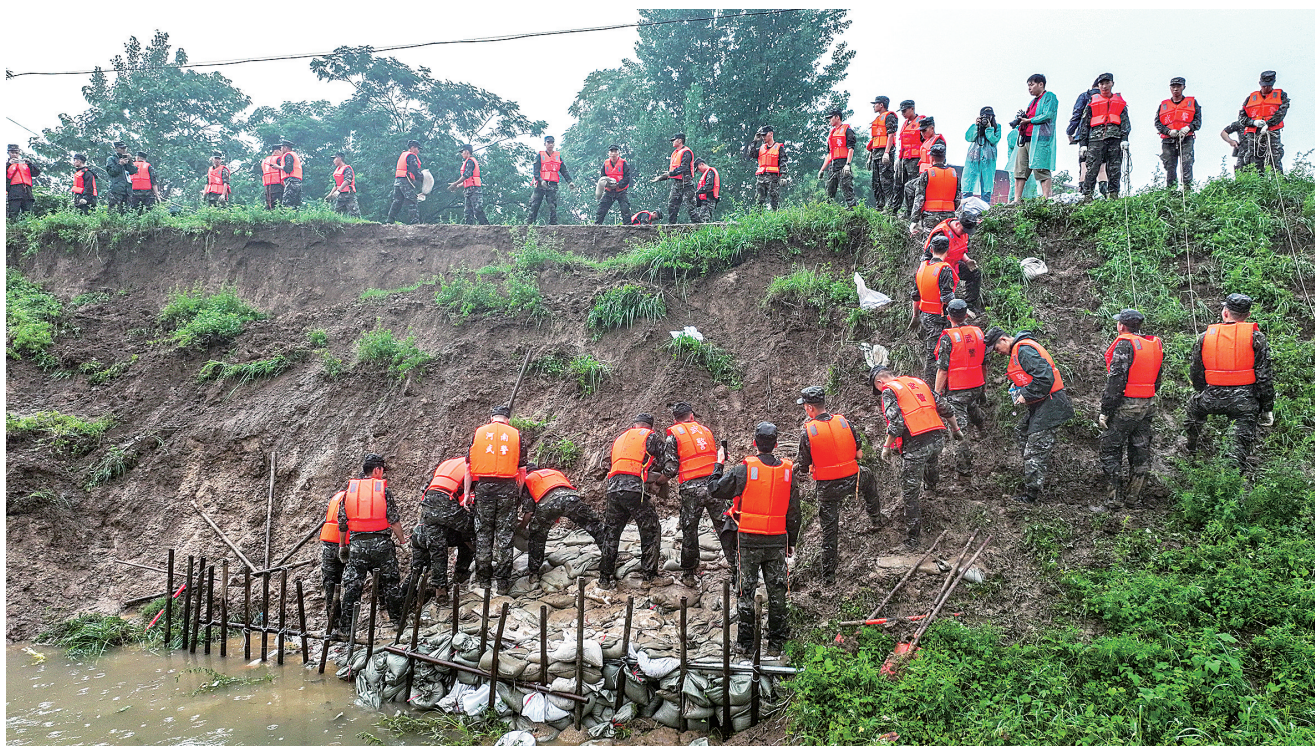
7月16日,武警河南总队南阳支队官兵与社旗县干部群众一道对潘河河堤除险加固。②5 本报记者 崔培林 张兰 摄
