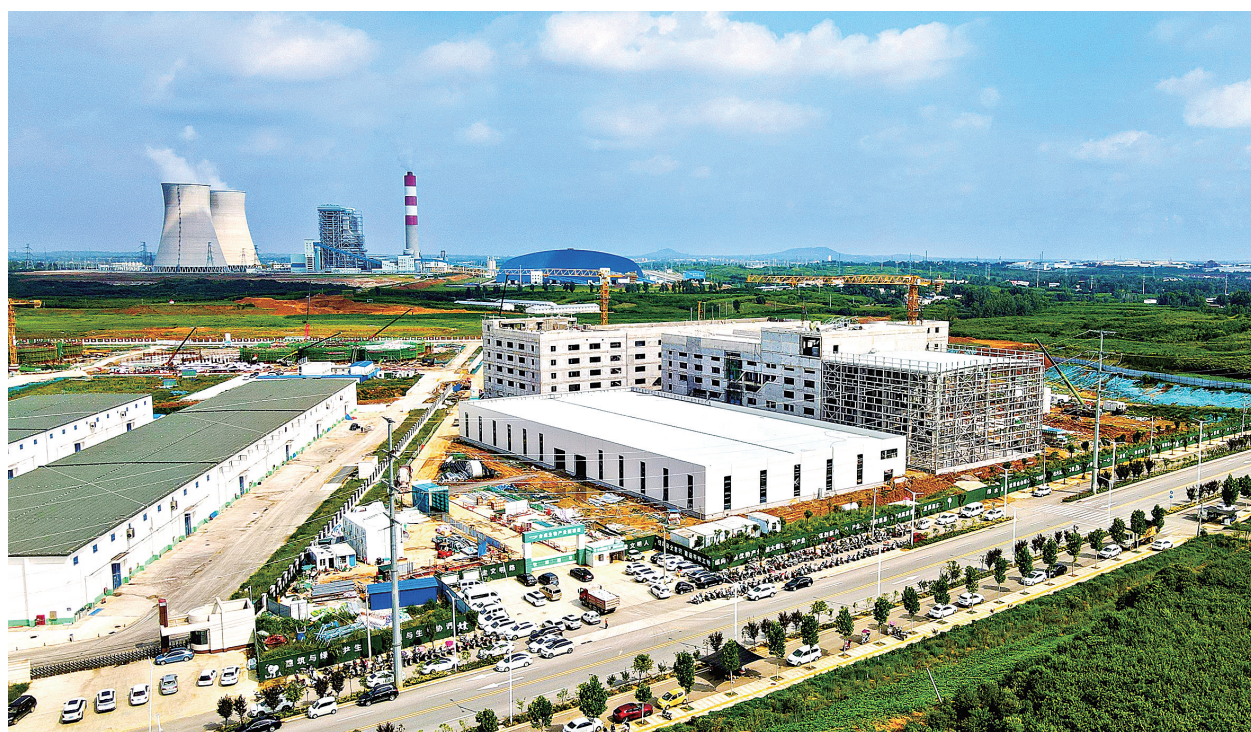
建设中的内乡县合成生物产业园。
