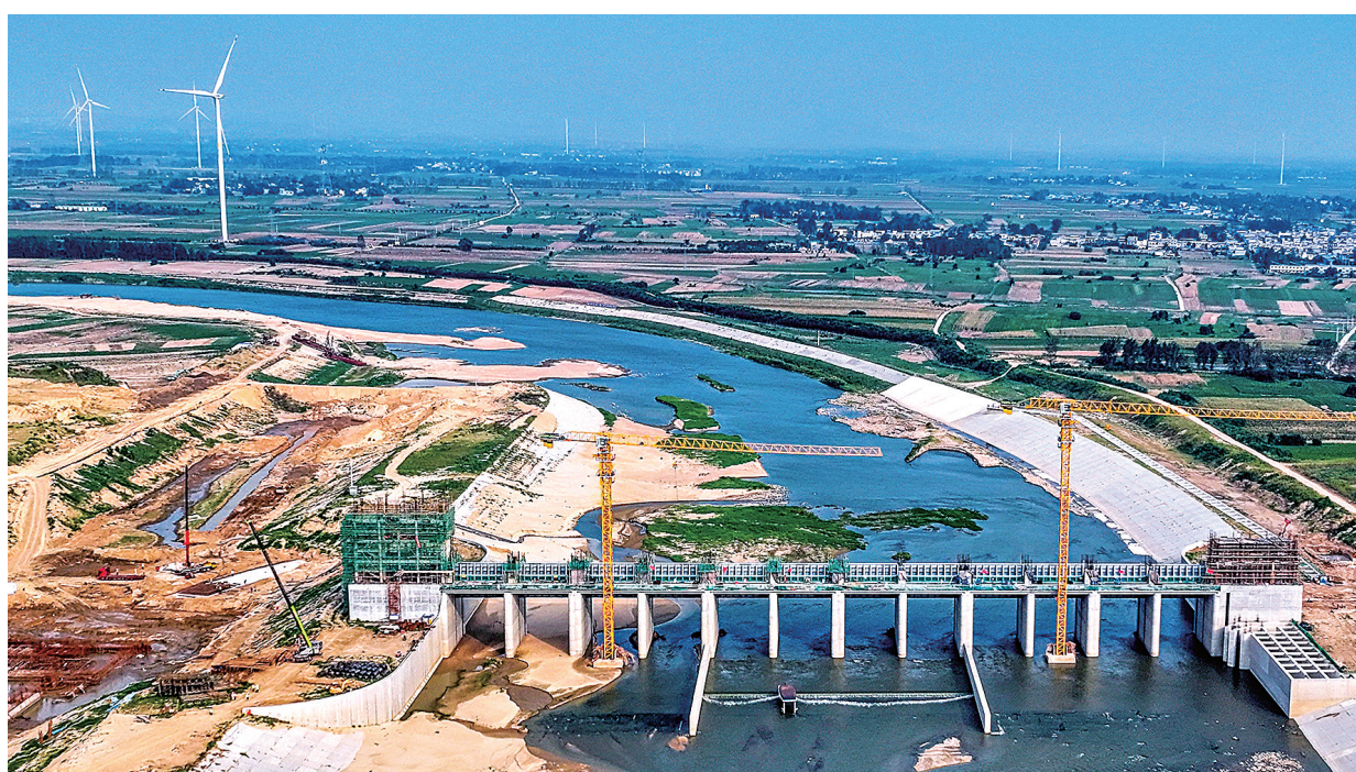
唐河复航项目一期郭滩枢纽泄水闸已实现通水。本报记者 崔培林 摄
