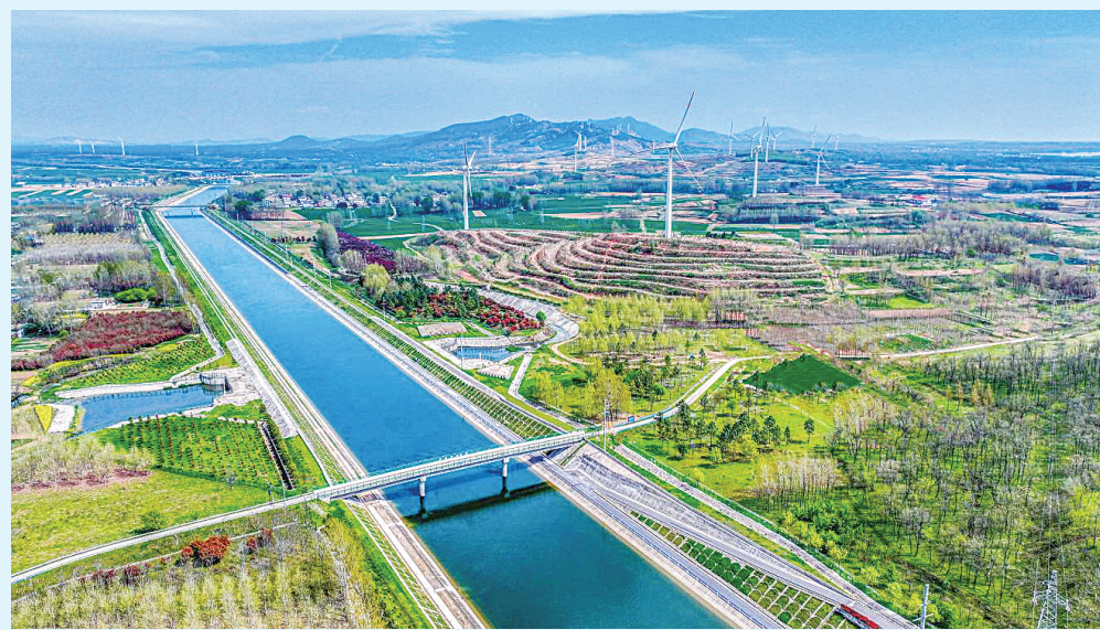
▲南水北调干渠通过方城道口。
