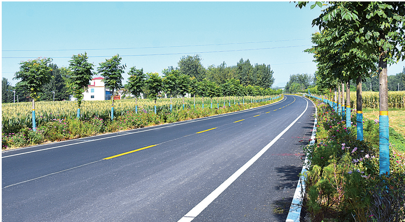
S329石桥白河桥至潦河坡段
