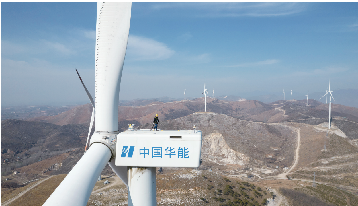
风电巡检维护工作人员在百米高空作业。全媒体记者 郑东丰 张浩摄
