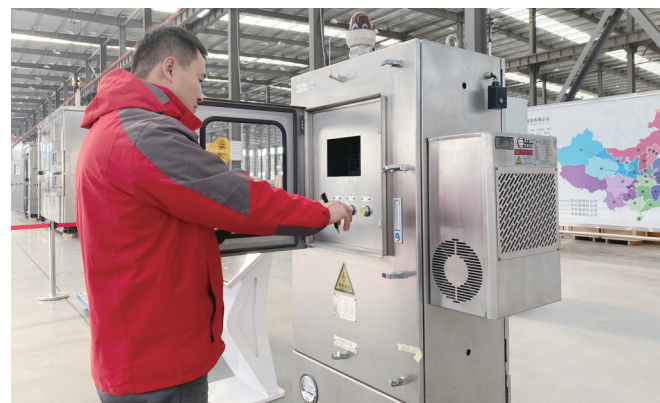
南阳中通智能科技集团有限公司工人正在检查设备。
