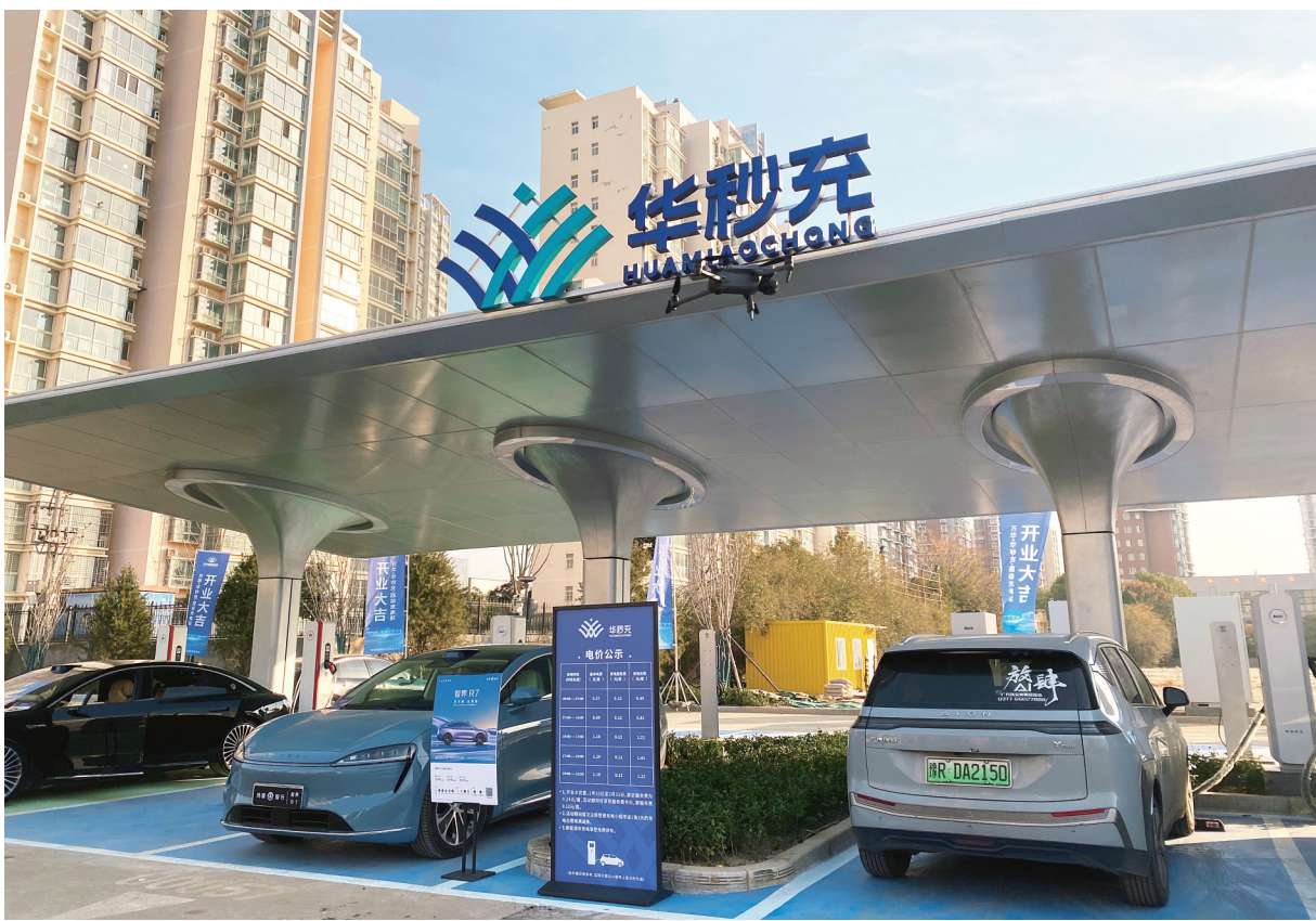
“华秒充”超级充电站吸引大量新能源汽车前来充电。
