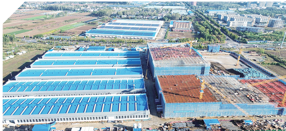
邓州市(嘉兴)化纤纺织及服装生产基地项目二期工程已显雏形。
