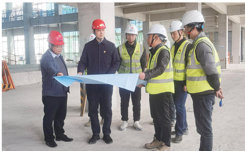
丁卫峰（左二）在检查施工情况。
